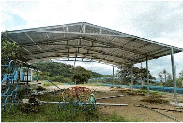
Foto 1: Instalación de techo con estructura tipo pórtico, con cobertura de lámina troquelada calibre 26.
