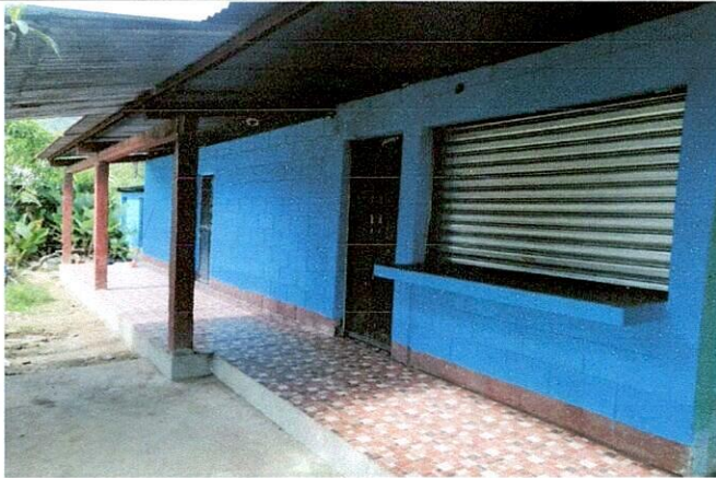
Foto 3: Instalación de piso granito, corredor de cocina y bodega.
