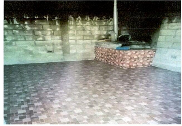
Foto 4: Mejoramiento de cocina, pintura, cambio de ventana por cortina metálica, cambio de loza por piso de cerámico.
