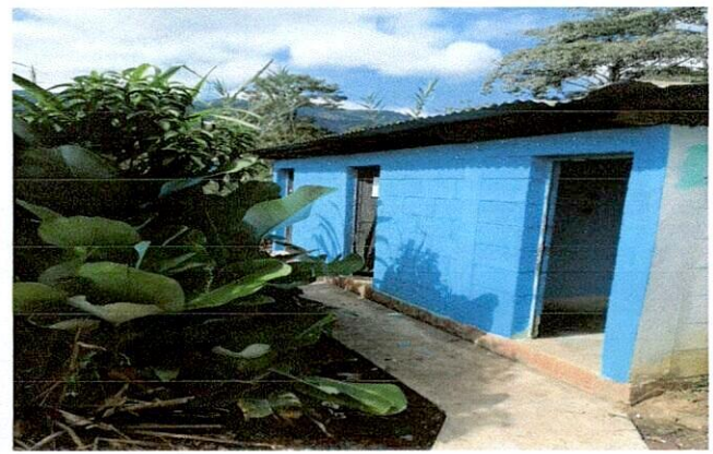
Foto 2: Realización de banqueta para unir los baños, mejoramiento de baños, instalación de agua con tubería de P.V.C. Entre otros
